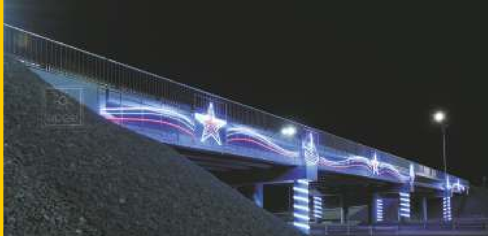
Декоративная подсветка путепровода Заказчик - ЗАО «ВАД», 2016 г.
